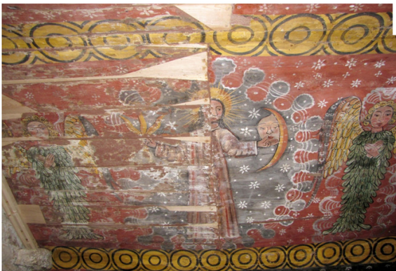
MISE EN PLACE DU LAMBRIS NEUF: BEAUCOUP DE DÉCOR RÉCUPÉRÉ, NÉCESSITÉ DE NOMBREUSES RETOUCHES ET RECONSTITUTIONS DE DÉCOR
