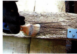
Durcissement des bois fragilisés (xylophages) par imprégnation de résine
