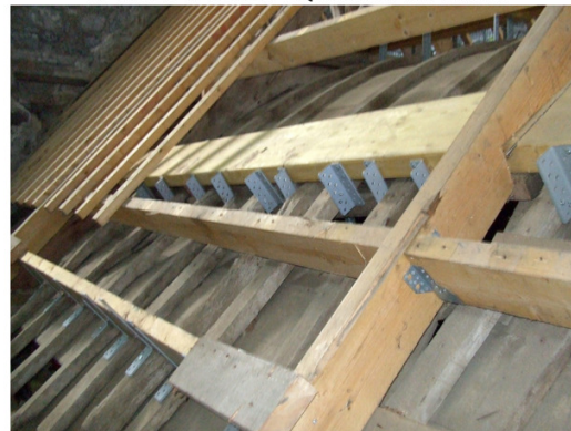
4 : montage des poutres et pannes
