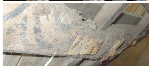
13 : Récupération des lambris 15 : Suppression de tirants métalliques
