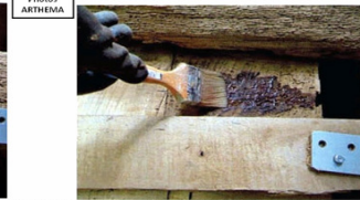
Durcissement des bois fragilisés (xylophages) par imprégnation de résine
