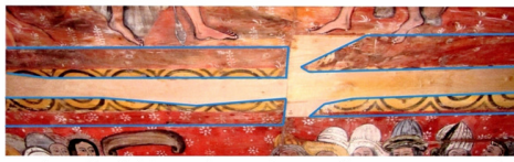
LES DÉCORS RÉCUPÉRÉS (ENTOURÉS DE BLEU) SONT COLLÉS SUR DU BOIS NEUF. APRÈS RÉCEPTION D'UNE TEINTE, LES PARTIES VIERGES SERONT DÉCORÉES.
