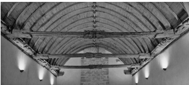
2 - Vue générale de la charpente avec sablières
